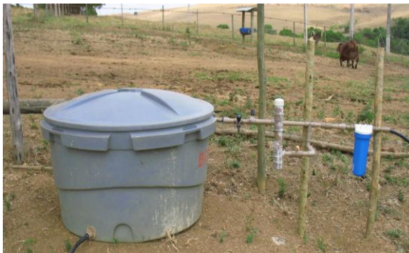
Figura 1: Sistema completo utilizando clorador de passagem artesanal em propriedade na região de Medeiros-MG
